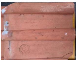
Tuile double romane estampillée, portant deux trous de fixation et une rainure de coin pour faciliter l'écoulement des eaux de pluie. Les firmes Browne et principalement Colthurst (ultérieurement Colthurst & Symons) sont les deux seuls types de tuiles anglaises trouvées en Bretagne.
