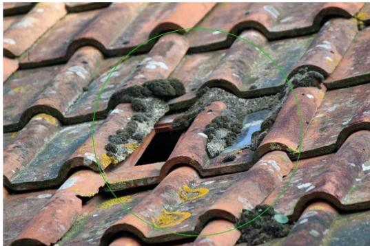
*La photo montre bien l'espace laissé à la manufacture dans la tuile gauche pour y poser un pavé de verre. A droite, ce pavé installé dans la tuile.*
